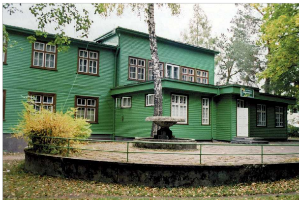
4 pav. Antano Juozapavičiaus vardo šaulių namai, kurhauzas (dabar kultūros namai), statyti 1938 m., archit. Adolfas Lukošaitis
