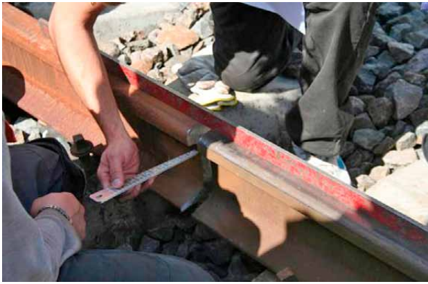
1 pav. Bėgių horizontaliosios plokštumos ir tarpo tarp bėgių nustatymas
