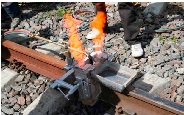
2 pav. Keraminių formų uždėjimas ant bėgių tarpo ir bėgių galų šildymas
